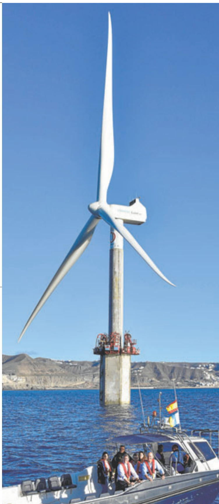
El único aerogenerador marino instalado en aguas españolas es el que se localiza junto a la Plocan, en Jinámar. ARCADIO SUÁREZ
